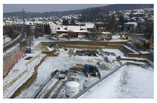
ING PLUS wurde bei der Wohnüberbauung «Im Grüntal» mit geodätischem Monitoring, Inklinometermessungen und diversen Absteckungsarbeiten beauftragt.
